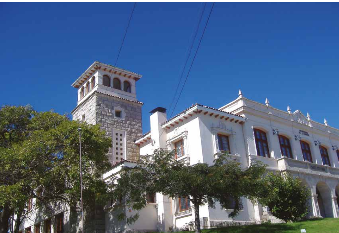
Edificio Universidad de La Serena
